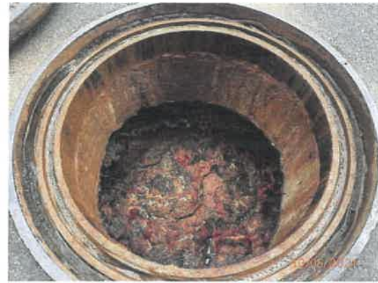
รูปที่ 16 การกำจัดไขมันออกจากปอดักไขมัน
