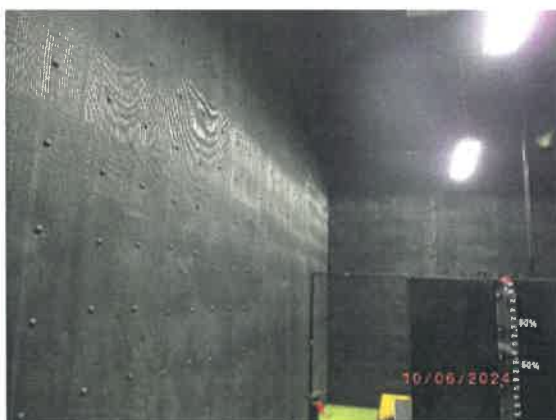
รูปที่ 43 ห้องเครื่องกำเนิดไฟฟ้าด้วยวัสดุกันเสียง
