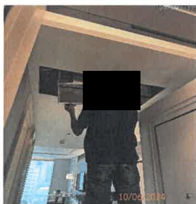
รูปที่ 46 บำรุงรักษาทำความสะอาดเครื่องปรับอากาศ
