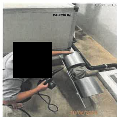
รูปที่ 46 บำรุงรักษาทำความสะอาดเครื่องปรับอากาศ
