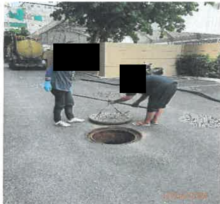
รูปที่ 16 การกำจัดไขมันออกจากปอดักไขมัน
