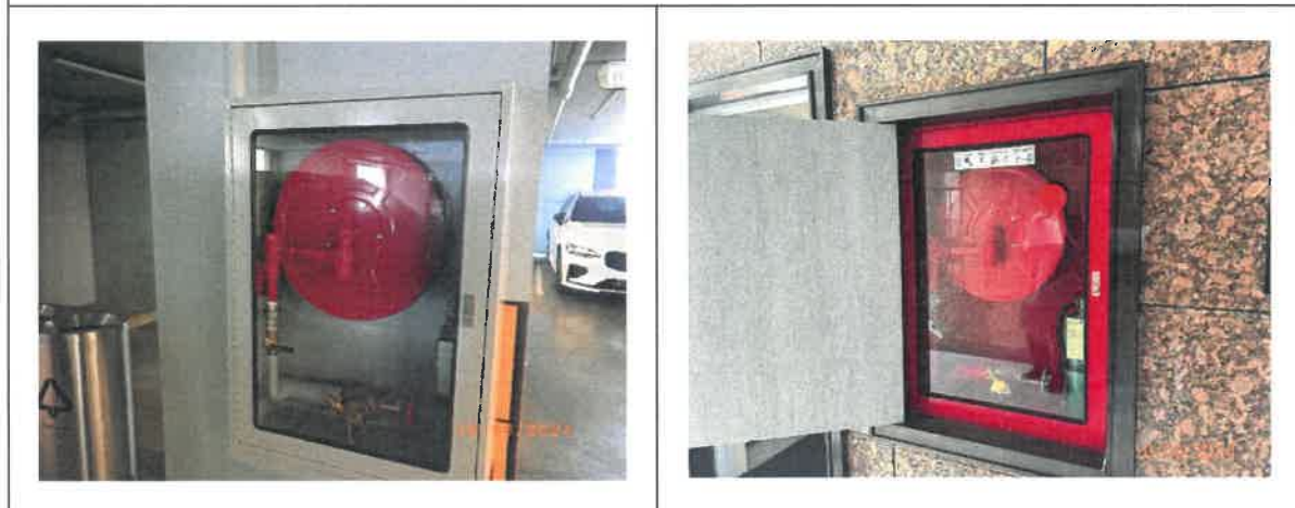
รูปที่ 48 ตู้เก็บสายฉีดน้ำดับเพลิงพร้อมอุปกรณ์ (FHC)
