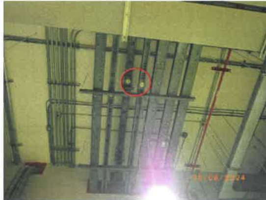
รูปที่ 41 เครื่องตรวจจับควัน (Smoke Detector) ภายในห้องหม้อแปลงไฟฟ้า
