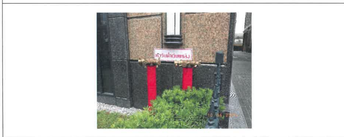
รูปที่ 49 หัวรับน้ำดับเพลิงภายนอกอาคาร
