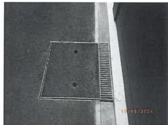
รูปที่ 29 บ่อพักน้ำตลอดแนวท่อระบายน้ำ
